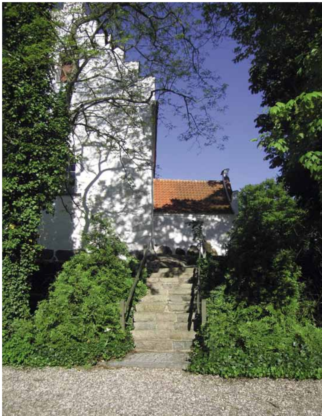
Butterup Kirke – hele kirkegården ligger hævet over det omgivende terræn. Adgang via det smalle trappeanlæg. Foto: Charlotte Skibsted.
